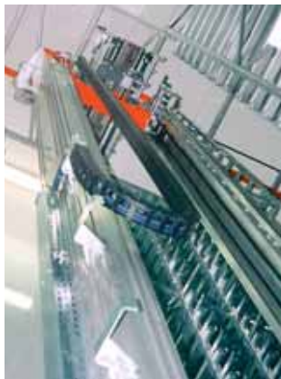
Hängender Einbau mit einseitigem U-Profil
