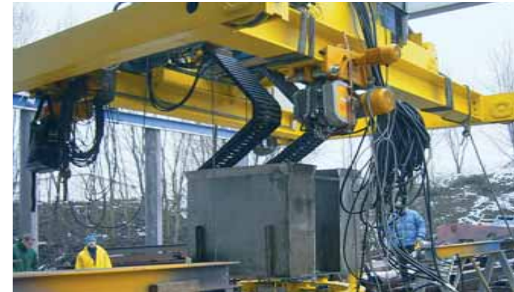
Zick-Zack Anwendung beim Abbau eines Kernkraftwerkes. Etwa 14 m hohe Stahlbehälter werden in kleine Späne für weitere Entsorgung gefräst
